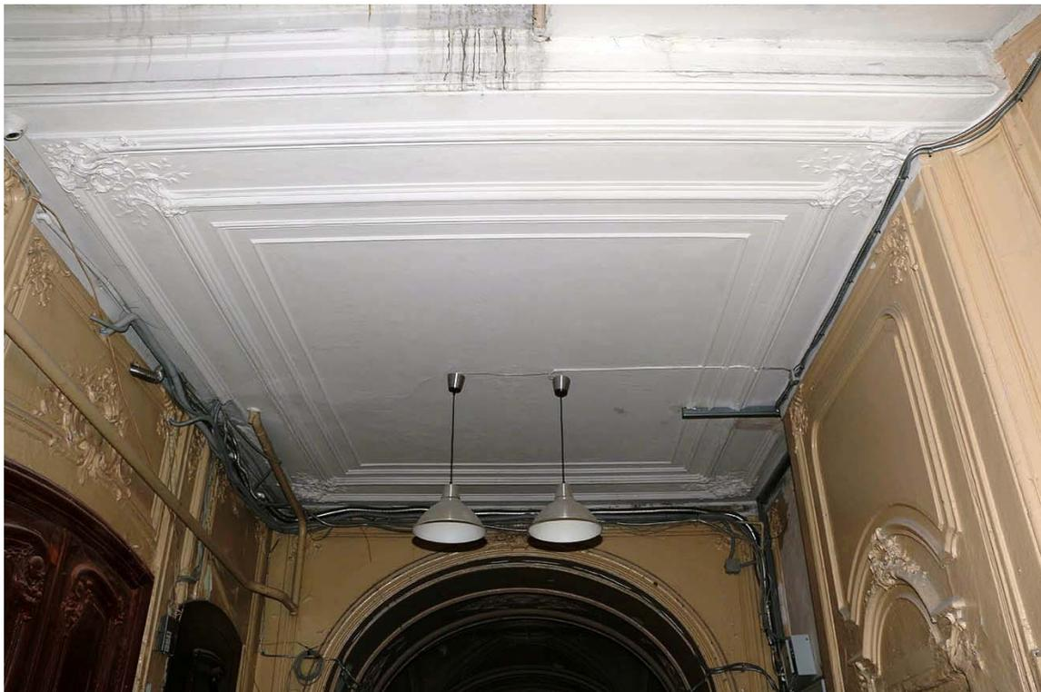
Фото 14. Конструкция примыкающей к помещению лестничной клетки №1 части потолка ее входной группы.
