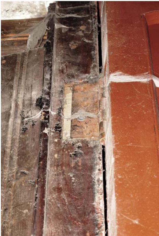
Фото 74. Новodelьная дверная петля не соответствует выборке древесины по размеру..
