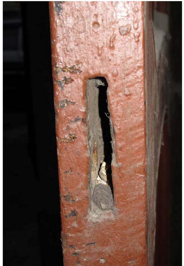
Фото 89. Старая выборка под крепление замка. Оригинальный замок утрачен.
