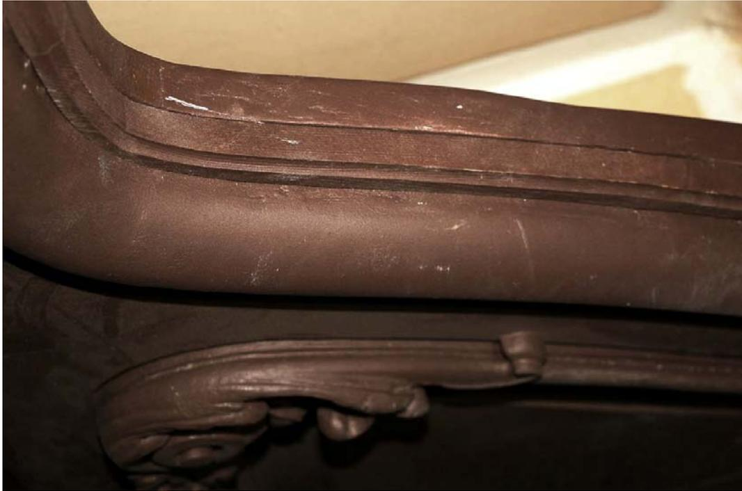
Фото 144. То же с другой стороны рамы. Целесообразны шпаклевание и грунтовка под проектную окраску согласованным колером.
