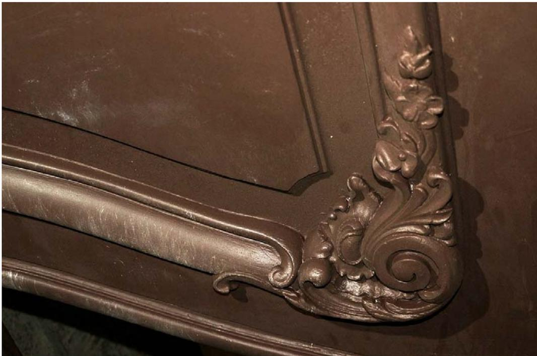
Фото 147. Существенных утрат, износа рельефа древесины не отмечено.
