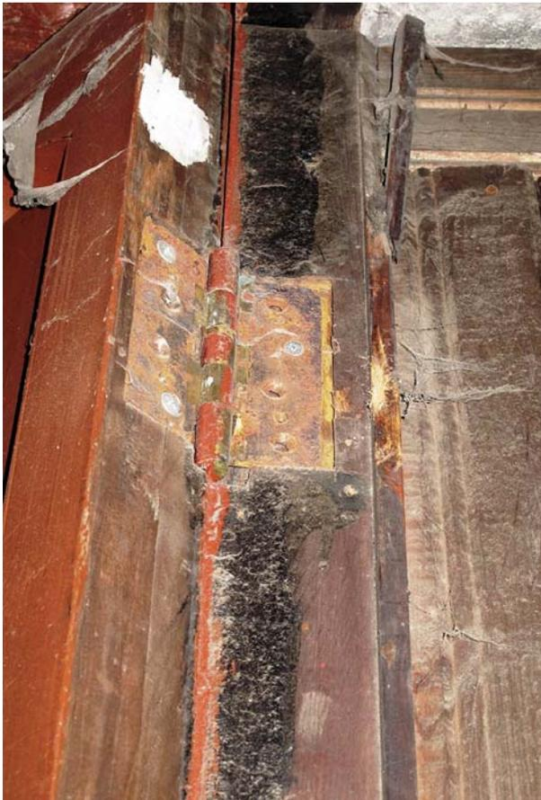
Фото 88. Петля подвергалась перемонтировке с использованием современного крепежа.
