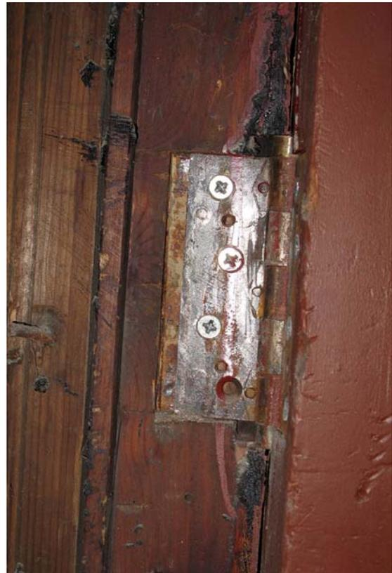
Фото 73. Новодельная дверная петля не соответствует выборке древесины по размеру.
