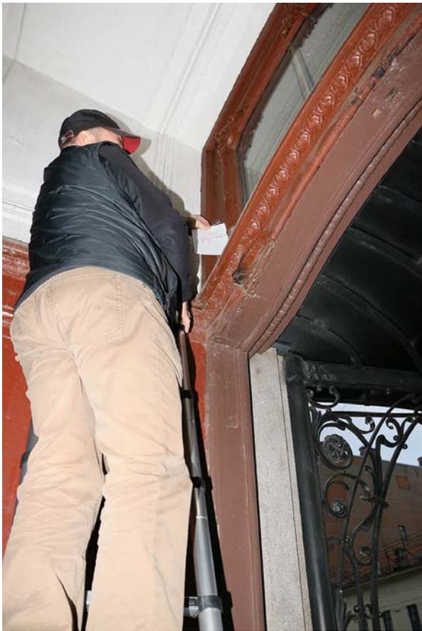
Фото 126. Образец №11. Окрасочные слои нижней части наружной фигурной фрамуги парадной №2. Место отбора образца.
