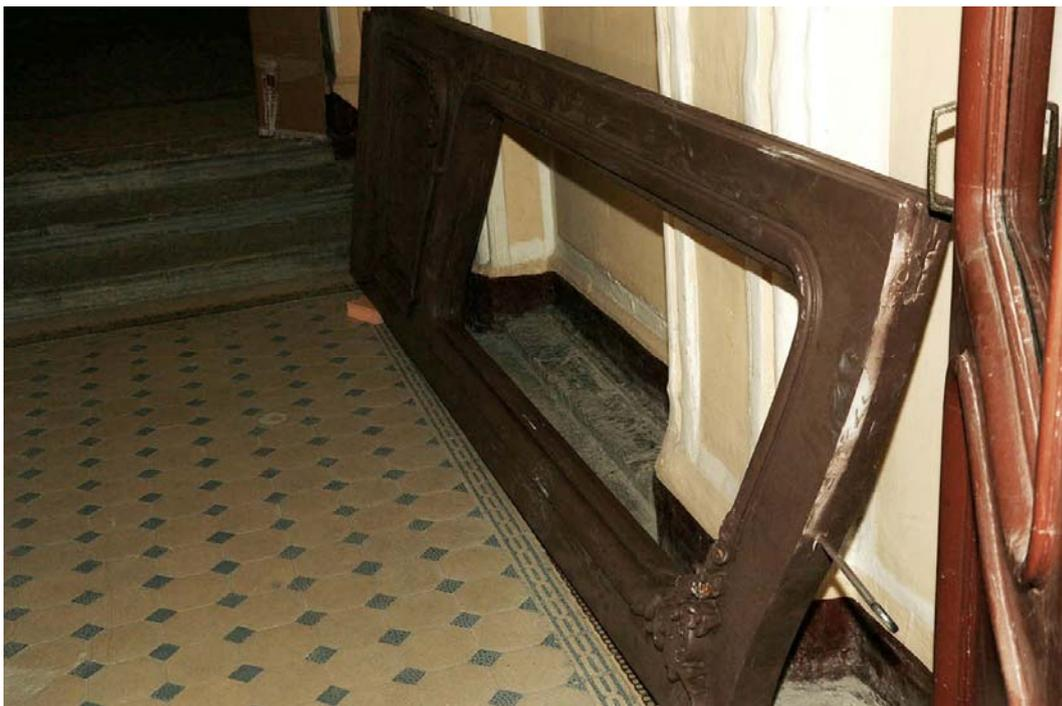
Фото 133. Общий вид отремонтированной створки наружной двери тамбура №1.
