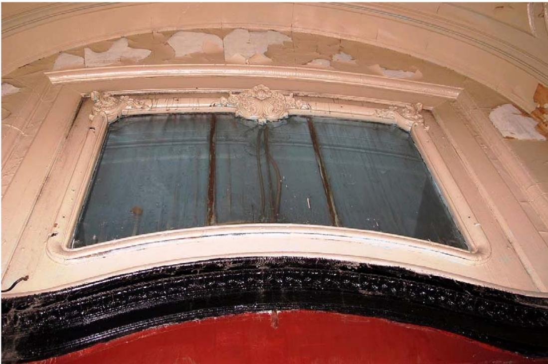
Фото 44. Вид на профилированную верхнюю часть дверной рамы
