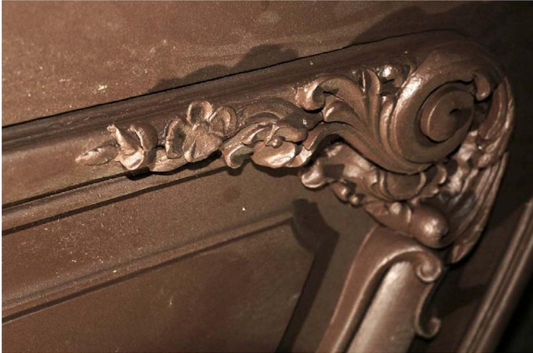
Фото 146. Существенных утрат, износа рельефа древесины не отмечено.
