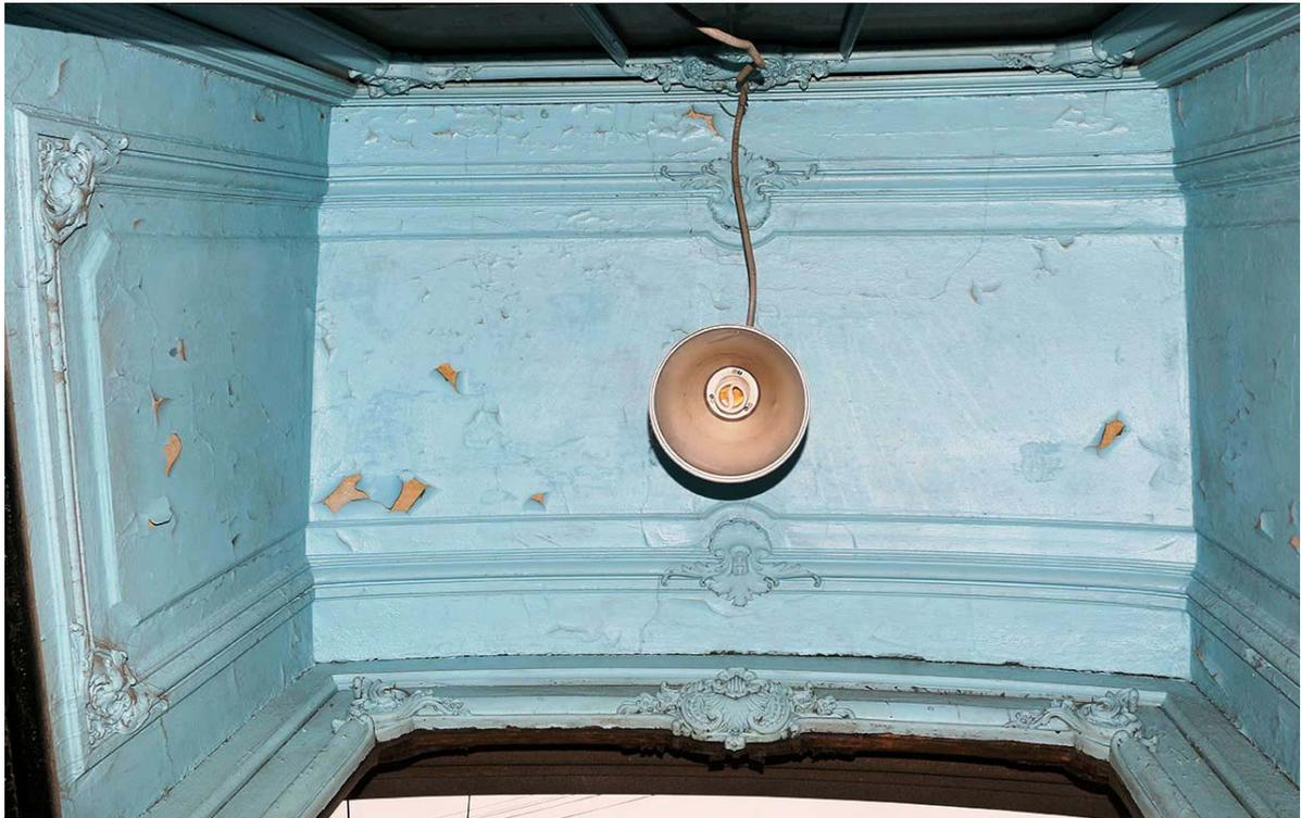
Фото 12. Крупный план потолка тамбура. Форма потолка определяется лучковой конструкцией перемычки проема в стене лицевого фасада здания.
