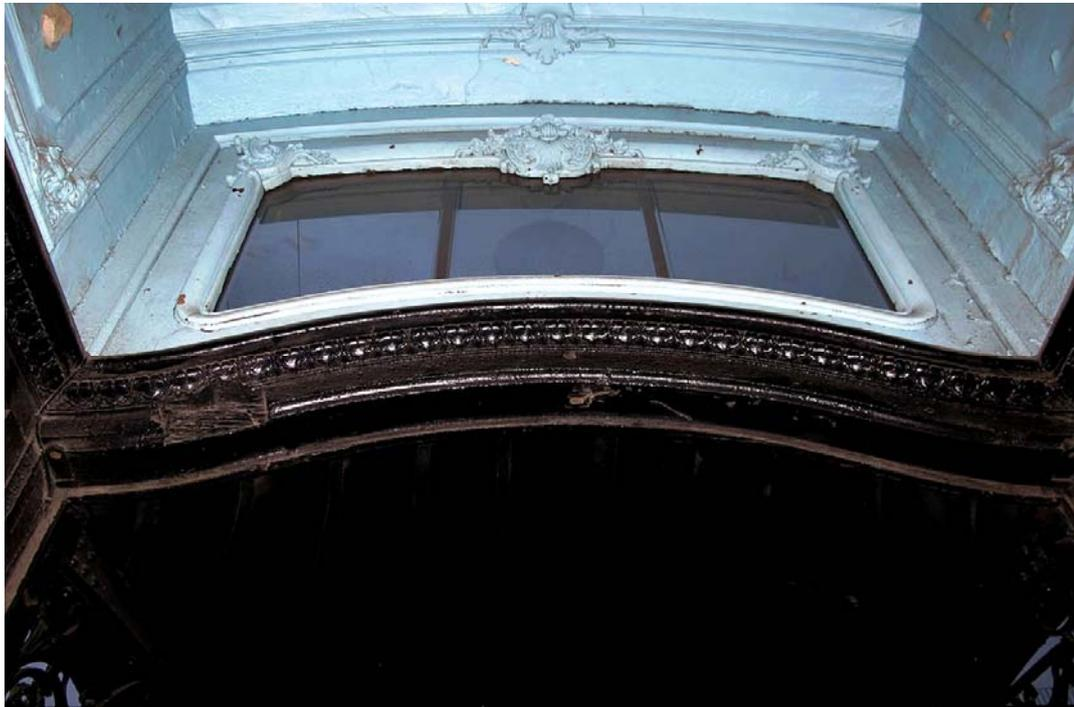
Фото 26. Техническое состояние профилированной верхней части дверной коробки наружных дверей тамбура №1. Слева – вырублена часть массива древесины коробки.
