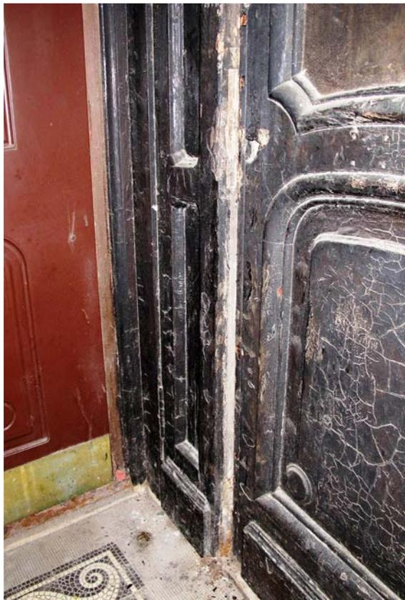
Фото 20. Техническое состояние притворной части узкой створки правой двери.
