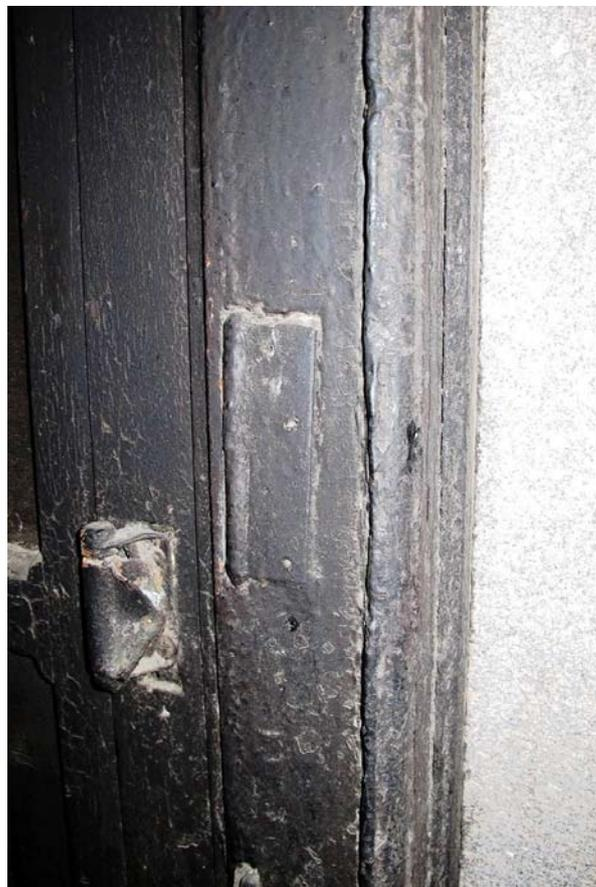
Фото 35. Состояние дверной коробки наружных дверей справа. Старые дверные петли в недопустимом техническом состоянии.
