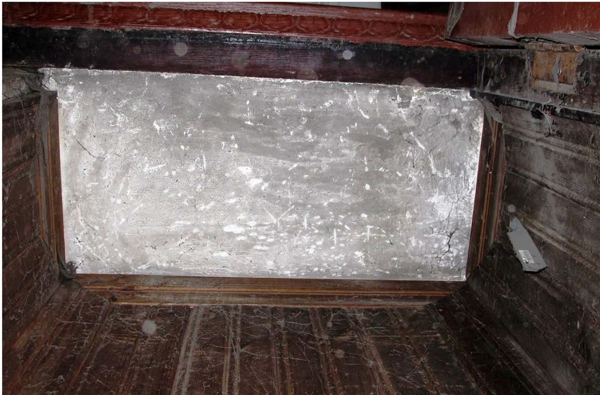
Фото 77. Вид потолка в правой секции правого от входа вспомогательного помещения тамбура №2. Обшивка из вагонки в удовлетворительном техническом состоянии.
