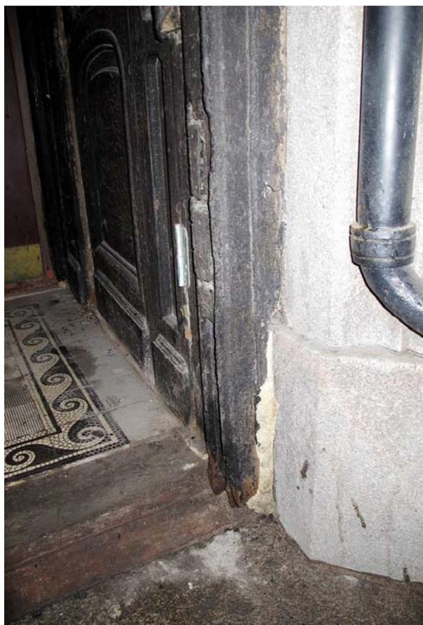
Фото 32. Техническое состояние дверной коробки наружных дверей справа.
