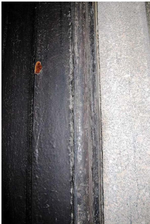
Фото 36. Окраска дверной коробки наружных дверей и дверных полотен боковой двери во вспомогательные помещения нуждается в замене в соответствии с исторической окраской при возведении здания.
