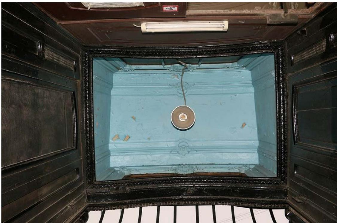
Фото 11. Конструкция верхнего объема тамбура №1. Внизу фото виден каркас над входом козырька.
