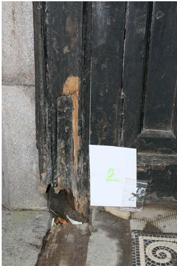
Фото 105. Образец №2. Отщеп древесины с историческими окрасочными слоями нижней левой части наружной дверной коробки парадной №1.
