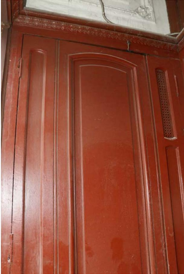
Фото 48. Устройство тамбура. Дверь слева во вспомогательное помещение тамбура.
