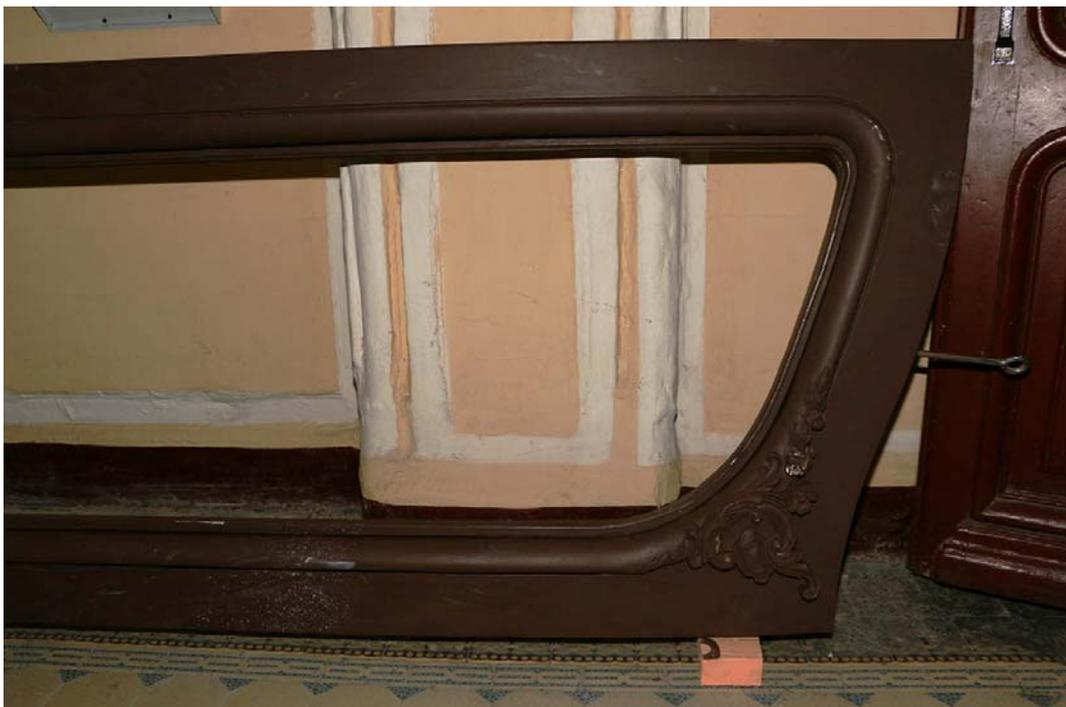
Фото 136. Вид рамы верхней филенки створки наружной двери тамбура №1. Верхняя и средняя часть рамы.
