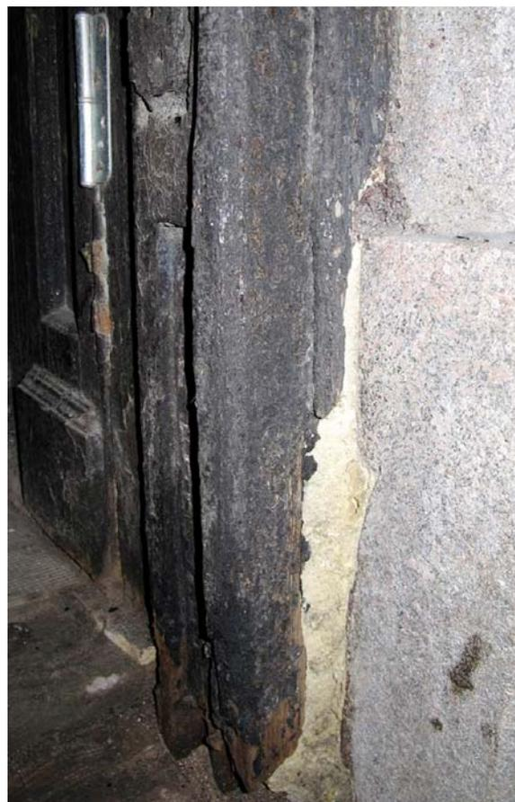
Фото 33. Часть дверной коробки справа утрачена на высоту до 0,4 м из-за поражения древесины гнилью.
