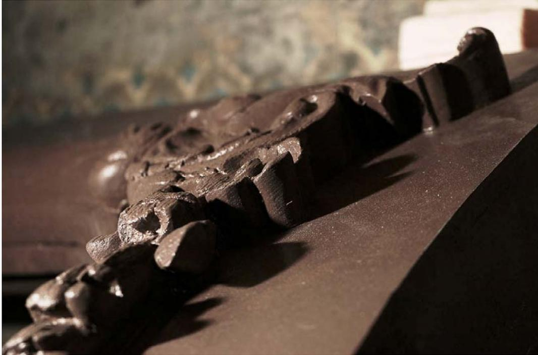
Фото 154. Техническое состояние резных украшений с обратной стороны створки.
