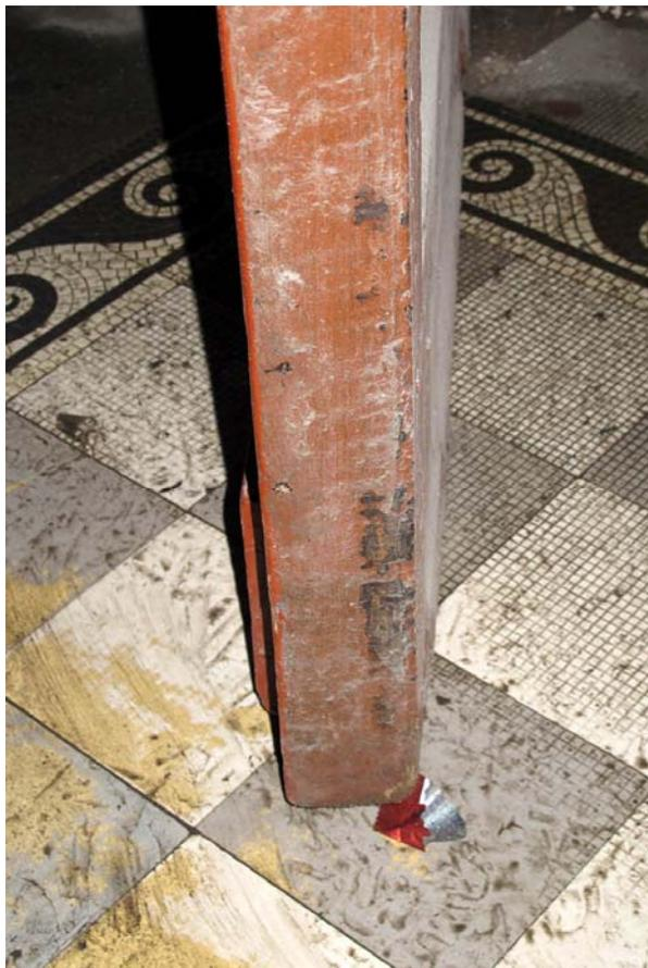
Фото 90. Техническое состояние нижней части дверного полотна широкой створки.
