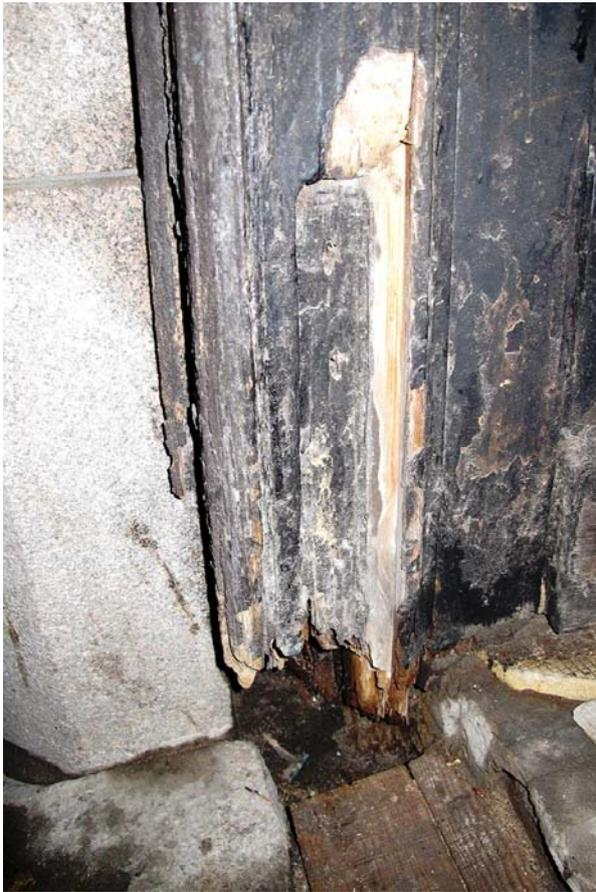
Фото 38. Техническое состояние дверной коробки наружных дверей слева. Часть дверной коробки утрачена из-за поражения гнилью.
