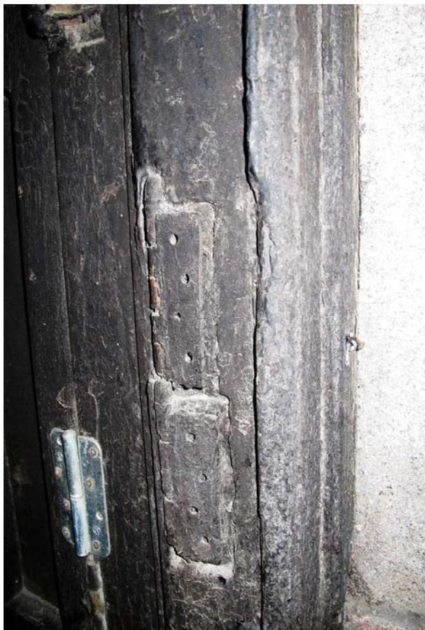
Фото 34 Состояние дверной коробки наружных дверей справа. Старые дверные петли в недопустимом техническом состоянии.
